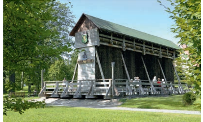
Das Gradierwerk Bad Münster
