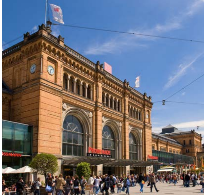
محطة القطارات الرئيسية في هانوفر - Central Railway Station
