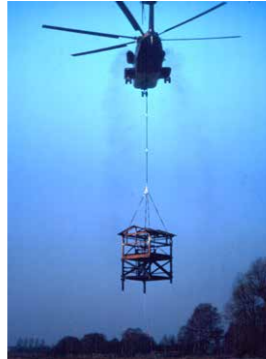
Hubschraubereinsatz: Einfliegen des Aussichtsturms
