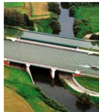
Flutbrücke über die Leine
